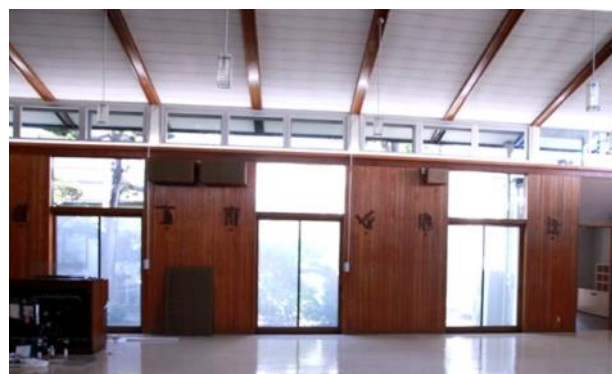
昼間の北面。上部の窓枠外側に寝かした梯子型の鋼製構造物を設置したから、床近くのガラス戸が光・風を通す。ここでも建築当初の姿が保たれた。
